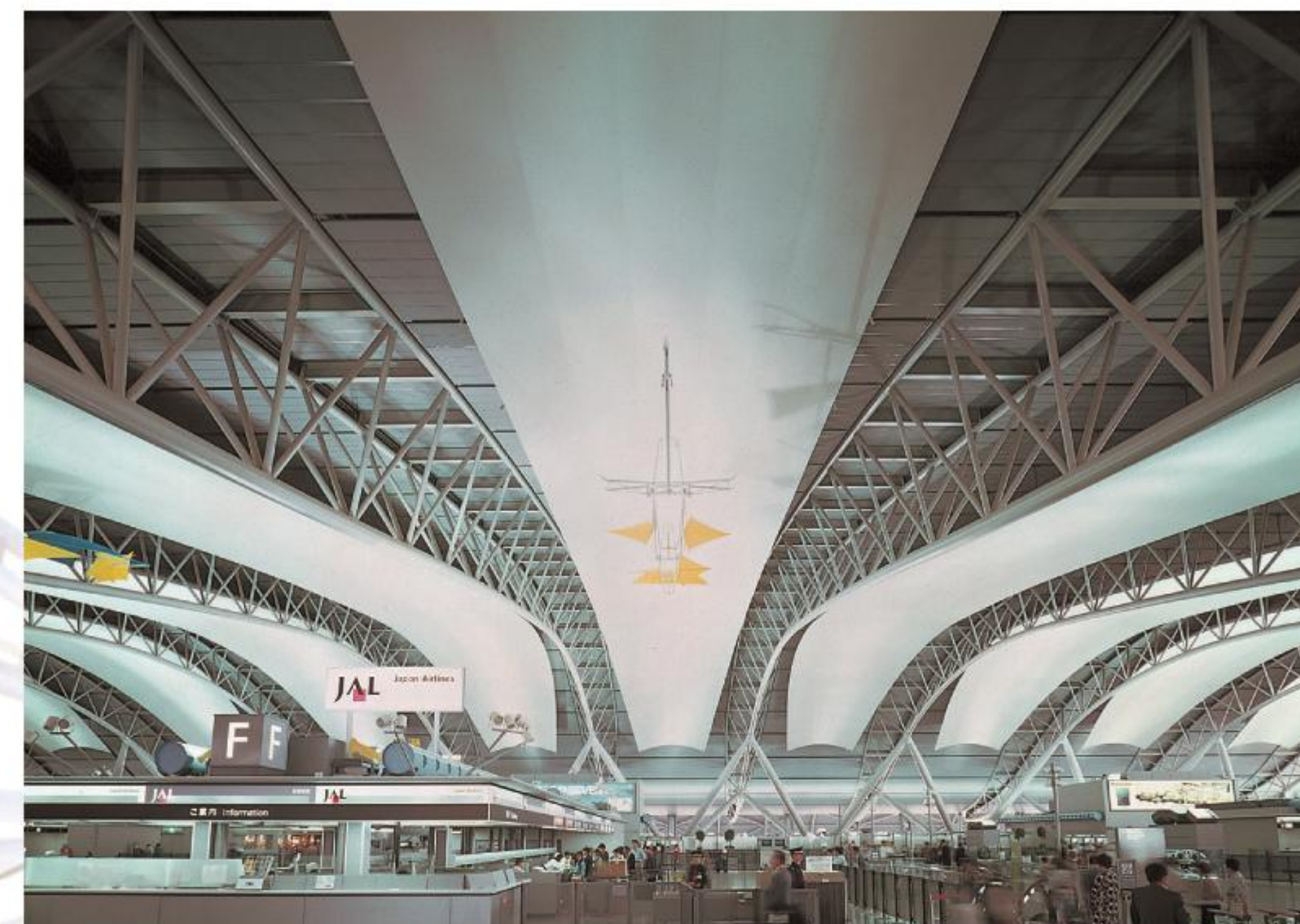
93 关西国际空港旅客候机厅(使用膜材: PTEE膜材料)
